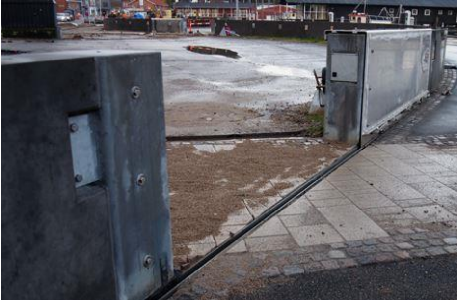
Højvandsmur i Lemvig udført i beton med påmonteret højvandsskot.
