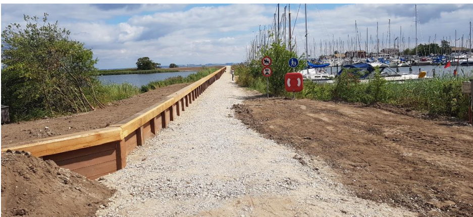
Eksempel på højvandsmur i Nivå udført som københavnerlæg i azobé (stolper og flager) med topafdækning i lærk.
